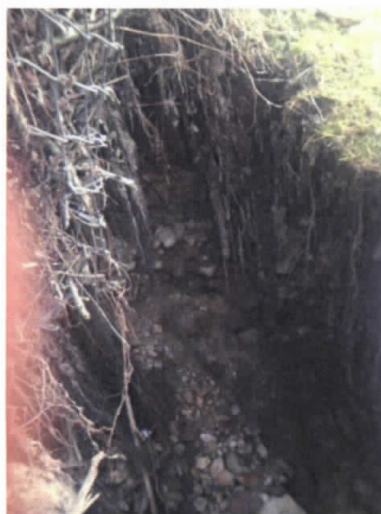
Foto 6. Eroziune mal – in spatele zidului
