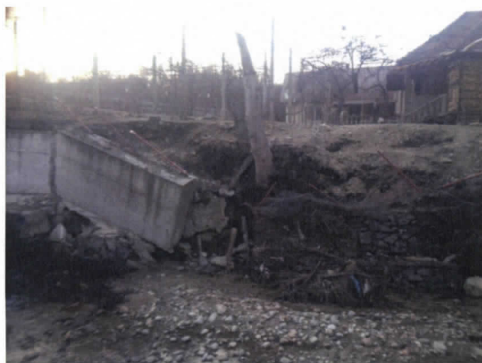
Foto 3. Zid de dirijare aval mal stang – rupt, deplasat si subspalat
