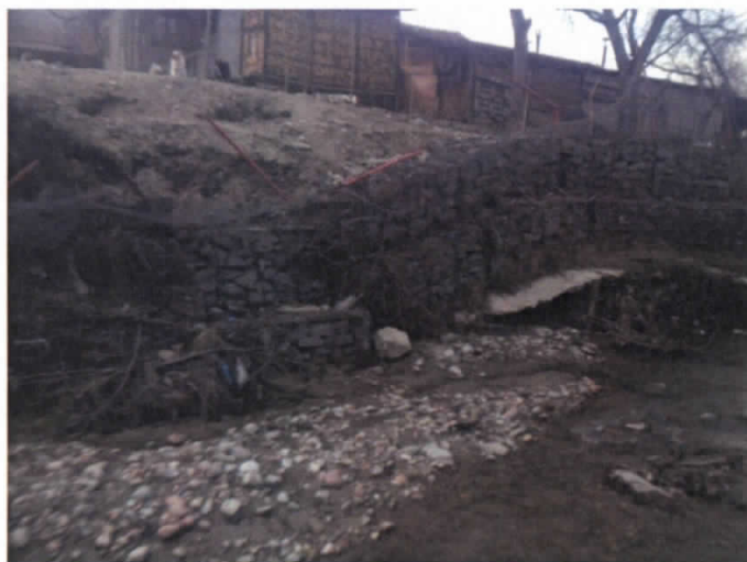
Foto 5. Aparare mal din gabioane – miscata din loc
