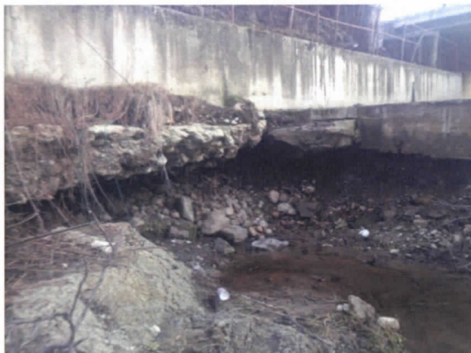
Foto 4. Zid de dirijare aval mal drept – baza degradata si subspalata
